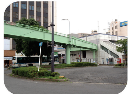
八千代台駅西口駅前広場
