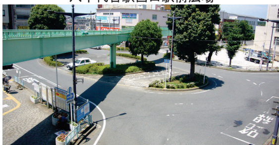
八千代台駅西口駅前広場
