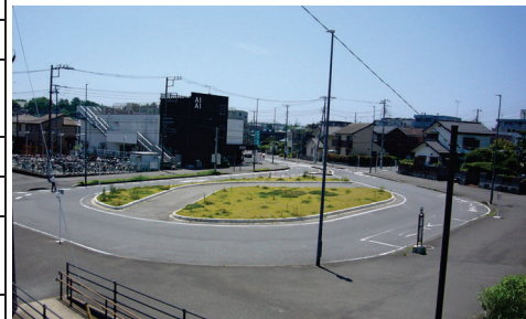
京成大和田駅南口駅前広場
